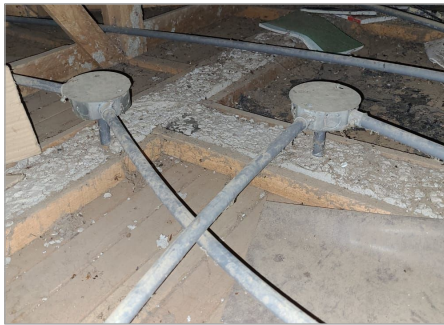
Instalación eléctrica entubada
