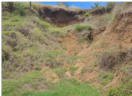
Terreno con deslizamiento
