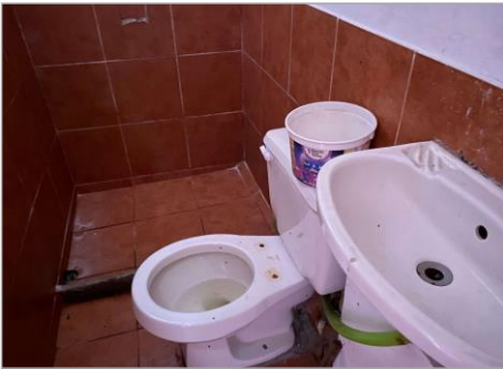
BAÑO PLANTA BAJA
