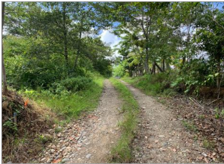
Calle pública frente a la finca - Sentido Sur a Norte
