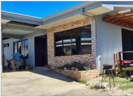
Vista exterior de la casa.
