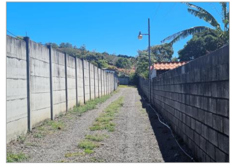
Detalle interior del callejón de acceso.
