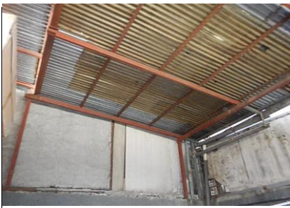
10. Estructura area pilas
