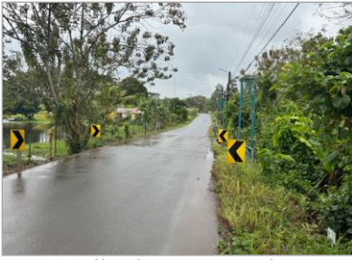
calle de acceso a la propiedad
