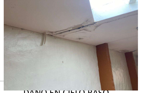
DAÑO EN CIELO RASO
