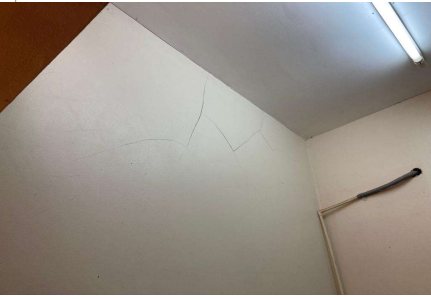
GRIETAS EN PAREDES
