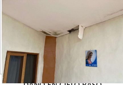
DAÑO EN CIELO RASO
