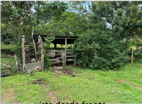
vista desde frente- escombros de instalaciones
