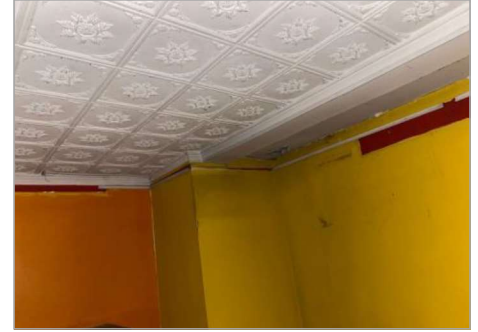
LOCAL PLANTA BAJA
