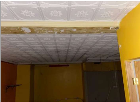
LOCAL PLANTA BAJA
