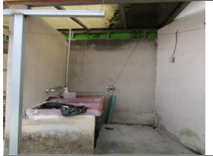
20. ÁREA DE PILAS
