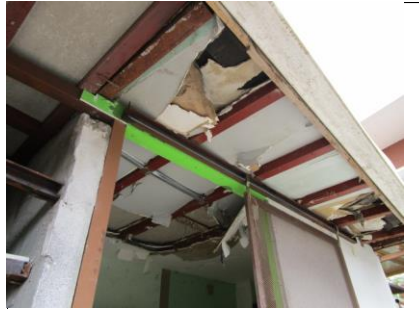
23. DAÑOS OBSERVADOS EN CIELOS DE LA BODEGA
