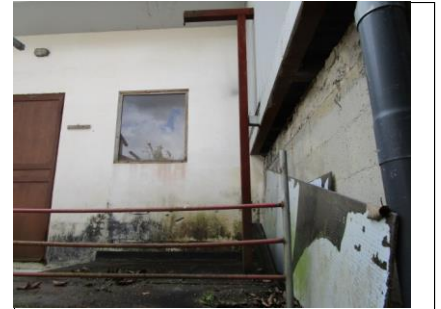
24. FALTA DE MANTENIMIENTO EXTERNO
