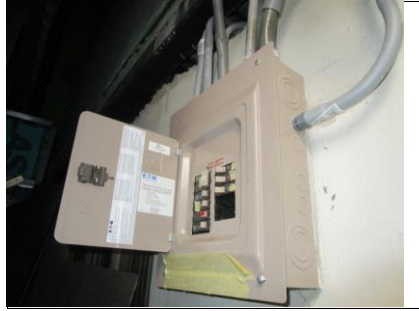
14. CAJA DE BREAKERS
