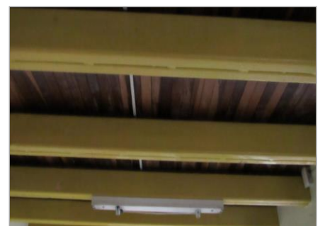
Estructura de entrepiso
