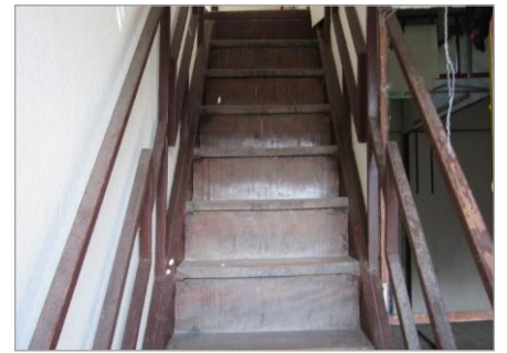
Acceso a 2do nivel
