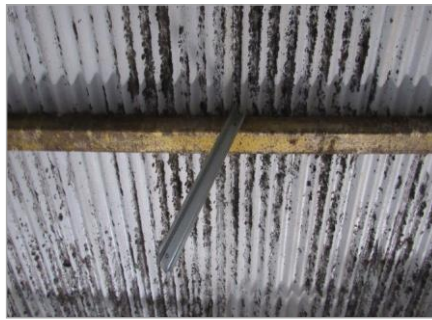
Estructura de techo y cubierta
