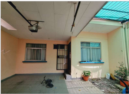
Fachada interna de vivienda
