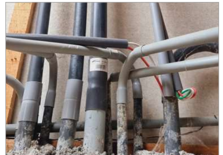
Instalación eléctrica entubada
