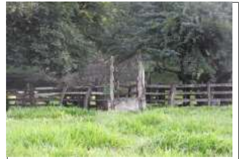
Cargadero de Corral no utilizado ya que la puerta de entrada esta cerrada
