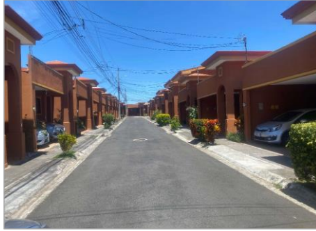
VISTA DEL CONDOMINIO
