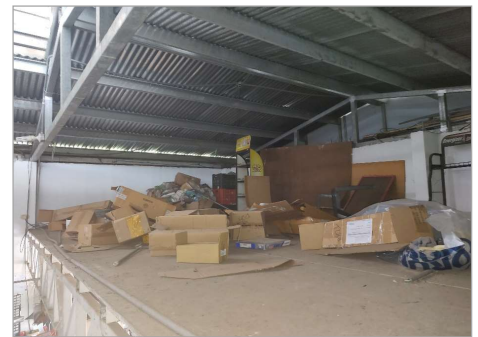
Vista interna del mezzanine
