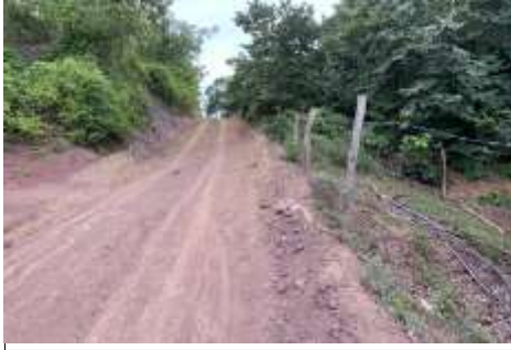
Calle de acceso.
