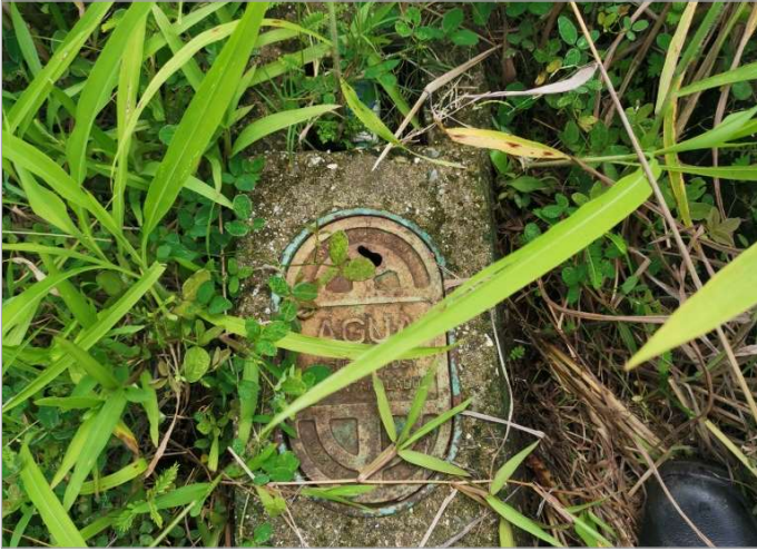
Medidor AyA instalado y habilitado frente a la propiedad
