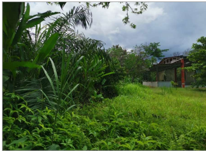
Lindero Oeste: canal artificial de drenaje
