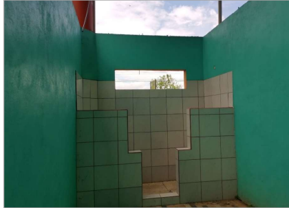
Cancha sintética: batería de baños
