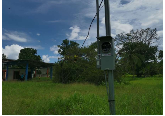
No hay medidor ICE. No hay servicio público de electricidad instalado
