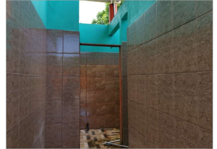
Cancha sintética: batería de baños
