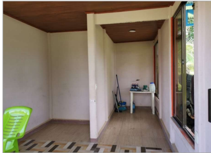
Local de lavado de vehículos: sala de espera-oficina
