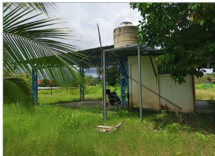
Local de lavado de vehículos: fachada trasera
