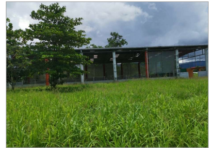
Vista general del sur a norte
