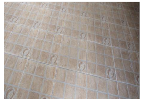
Acabado de piso
