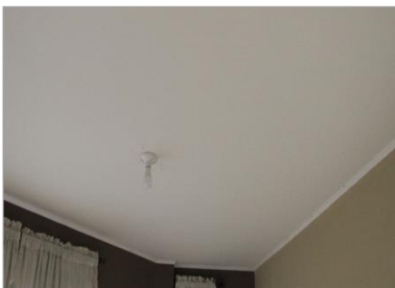
Acabado de cielos
