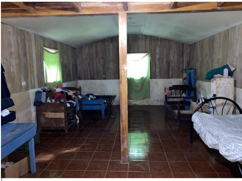
10. Dormitorio planta baja
