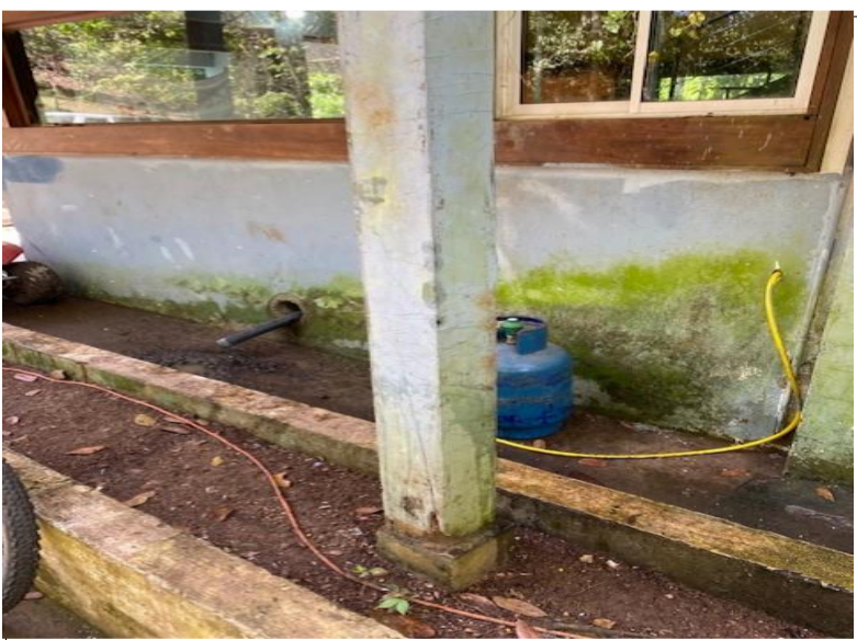
22. Paredes exteriores con humedad
