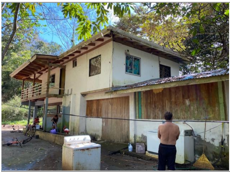
19. Fachada lateral norte
