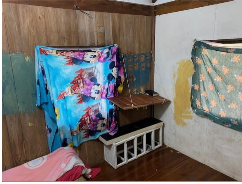
26. Paredes interiores en regular estado
