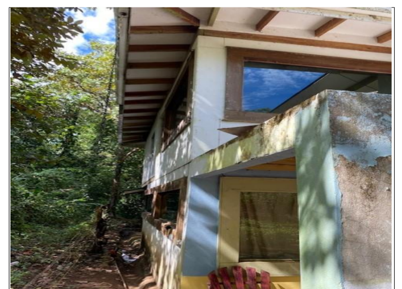
24. Fachada lateral sur
