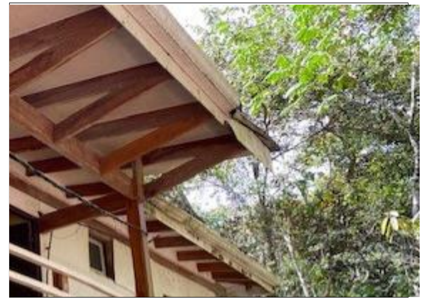
27. Alero y canoa con daños por caída de rama
