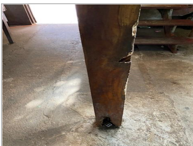
23. Columna interior en regular estado
