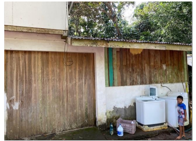
18. Área de pilas
