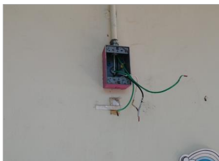
CABLES EXPUESTOS
