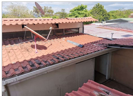
Foto 22. Cubierta del techo vivienda norte
