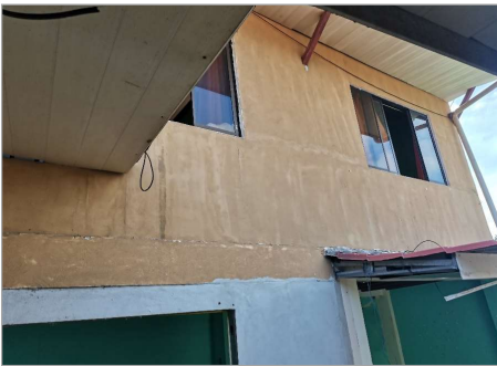
Foto 34. Nivel 2 vivienda sector sur
