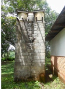
TANQUES PARA AGUA EN MAL ESTADO - NO SE INCLUYEN EN LA VALORACIÓN
