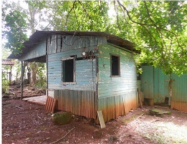
VIVIENDA DE MADERA EN MAL ESTADO - NO SE INCLUYE EN LA VALORACIÓN
