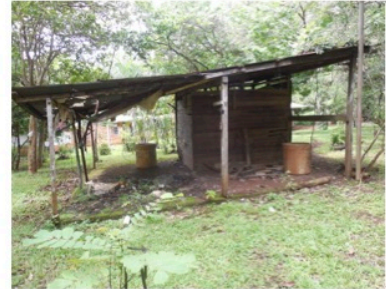
COBERTIZO DE MADERA EN ESTADO RUINOSO NO SE INCLUYE EN LA VALORACIÓN
