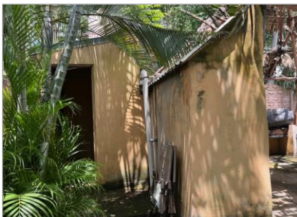
Exterior de servicio sanitario de rancho.
