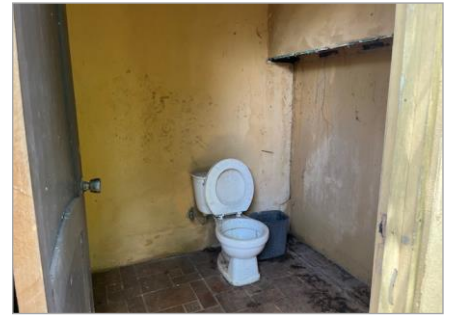
Interior de servicio sanitario de rancho
