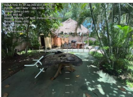
Losa de concreto
