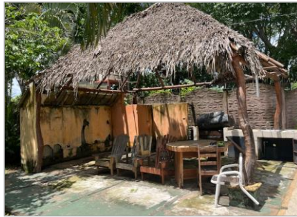
Rancho en estado de demolición
