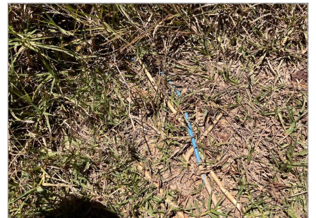
Cables expuestos
