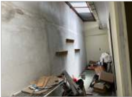
Area de tendido y pilas
