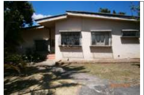
FACHADA FRONTAL CASA
