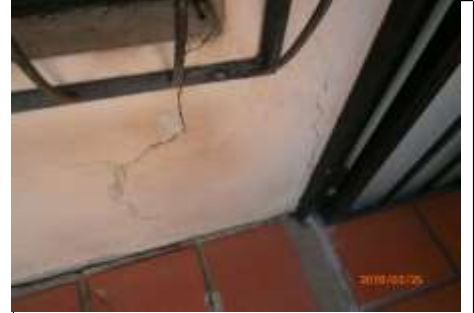
AGRIETADURA EN PARED
