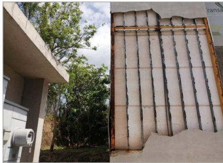
Estado de cerramientos frotal
