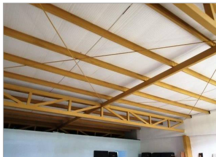
Estructura de techo
