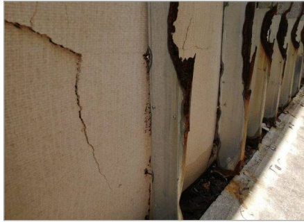
Estado de cerramientos posteriores
