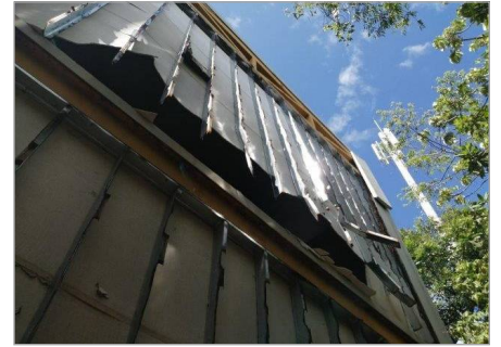
Estado de cerramientos posteriores
