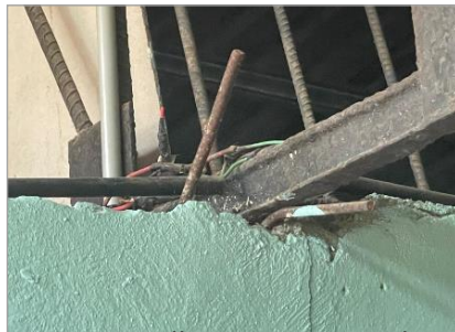
Detalle exposiciones de cables y pandeo cercha
