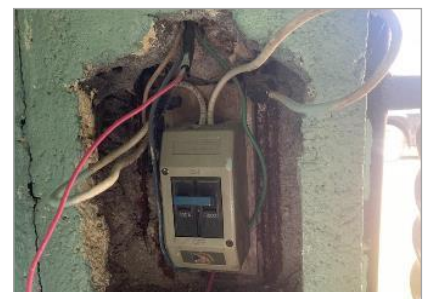
Detalle disyuntor 100 ampe, exposicion cables
