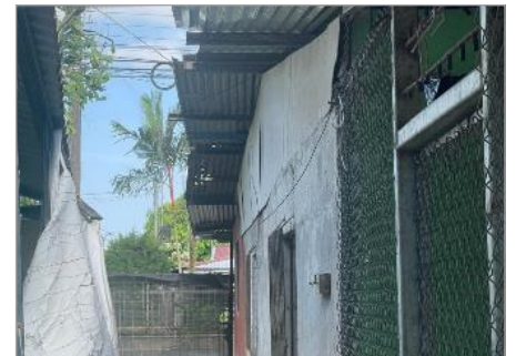
Vista de tapichel norte forro fibrocemento
