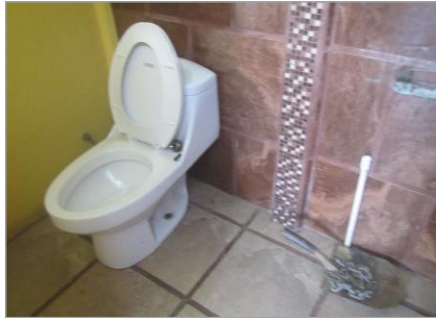
Baño de cabina 2
