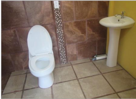
Baño de cabina 1
