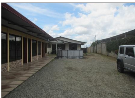
Espacio de esacionamiento
