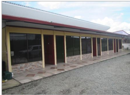
Fachada de las cabinas
