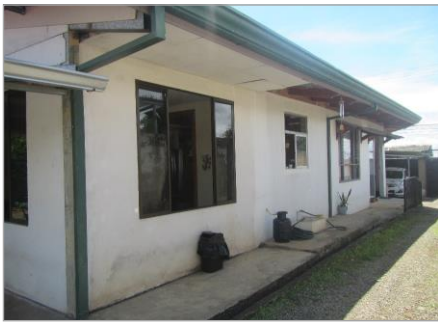
Fachada de la vivienda
