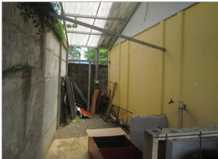
Tendido al lado de las cabinas
