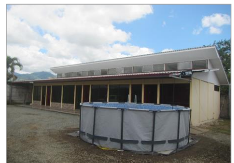
Vsita lateral de las cabinas
