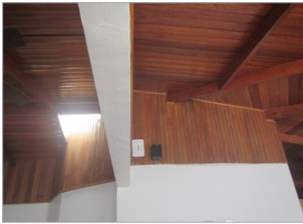
Detalle de cielo raso
