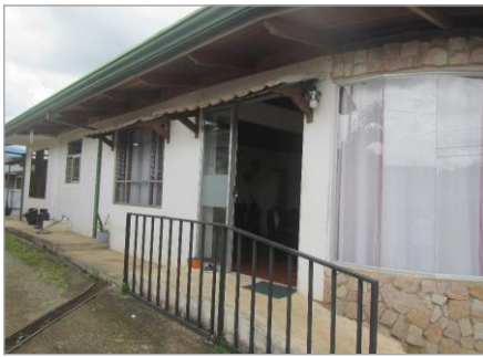
Fachada de la vivienda
