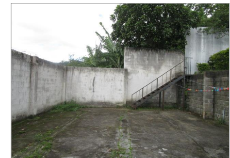
Patio Posterior / Tapias / Muro de Contención
