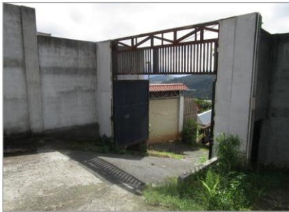
Acceso al Inmueble
