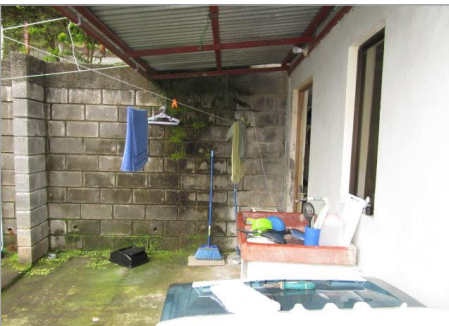
Área de Pilas
