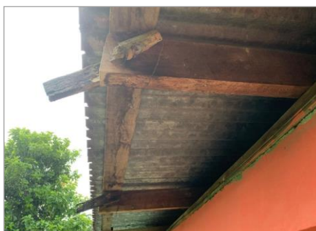
Estrcutura de techo
