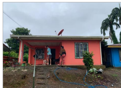
Vista frontal de la vivienda novalorada
