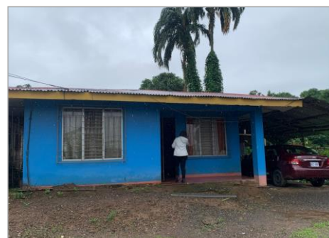
Vista frontal de 2da vivienda
