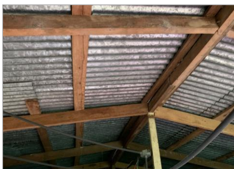
Estructura de techo
