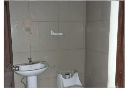
Detalles Internos - Primer Nivel
