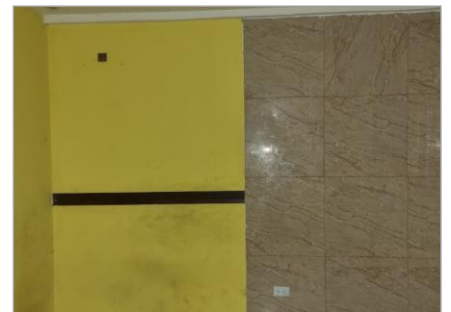
Detalles Internos - Primer Nivel
