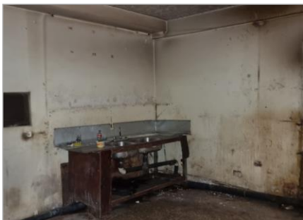
Detalles Internos - Primer Nivel
