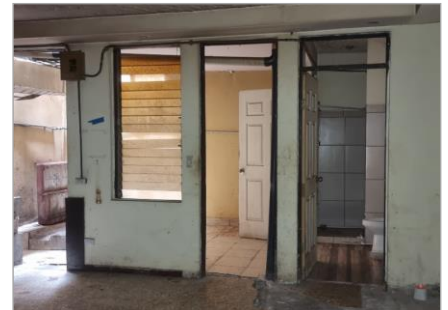
Detalles Internos - Primer Nivel
