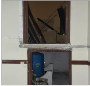
Detalles Internos - Primer Nivel
