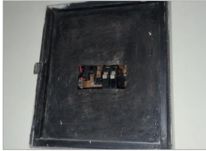
Detalles Internos - Primer Nivel
