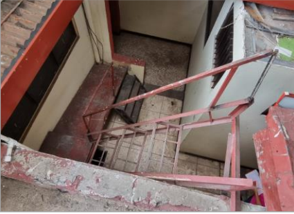
Acceso a Techos
