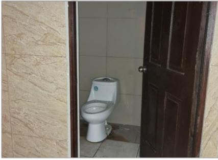
Detalles Internos - Primer Nivel
