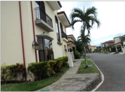
Vista de acabados de servicios
