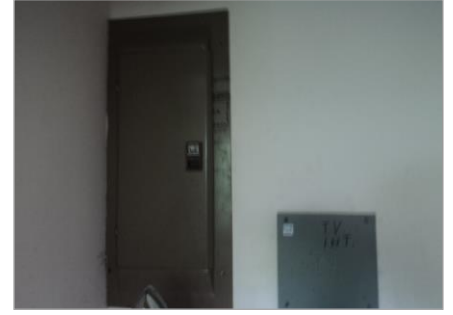
Vista de caja breakers
