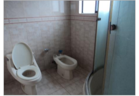
Vista de acabados en baño
