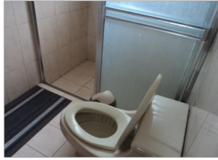
Vista de acabados en baño
