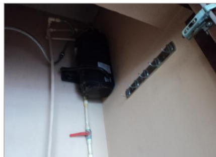
Vista de calentador de agua
