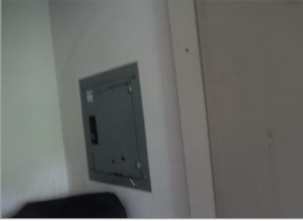
Vista de caja breakers
