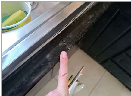
Sobre de mueble de cocina reventado
