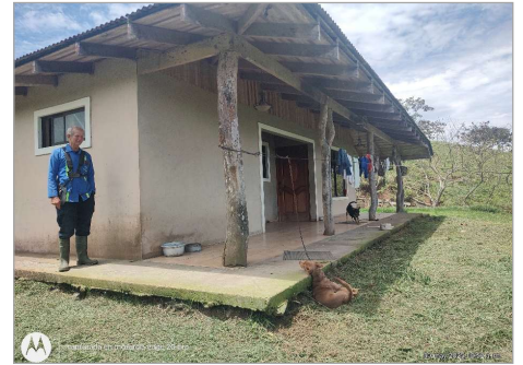
CORREDOR - FACHADA NORTER
