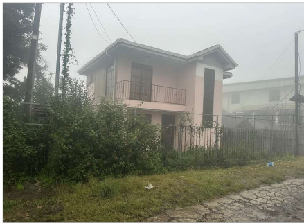
Vista lateral este
