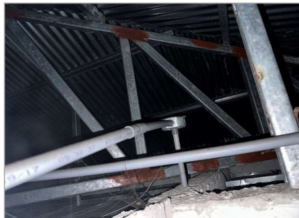
Cerchas, cubierta, entubado eléctrico
