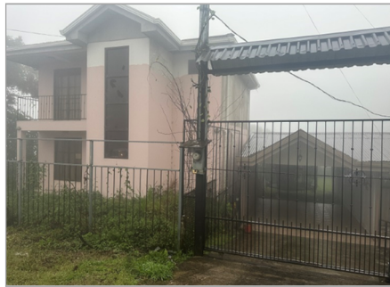
Vista lateral oeste
