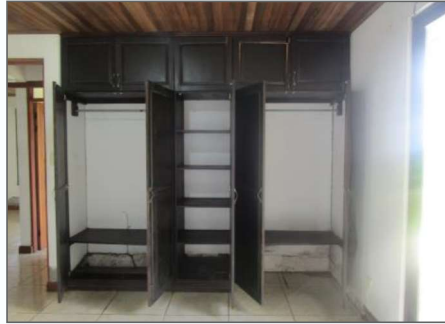
Closet de otro dormitorio, en mal estado
