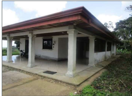
Fachada principal y lateral Este
