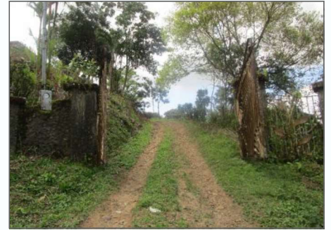
Vista de portones de acceso, deteriorados
