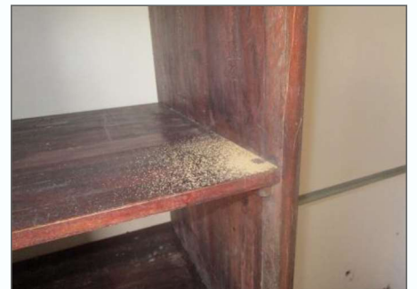
Presencia de comejen en closet
