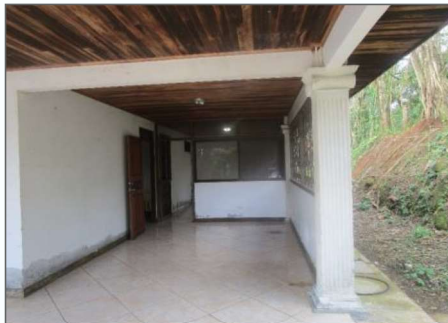
Corredor y área de pilas
