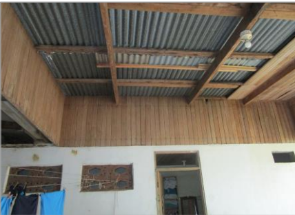
Estructura de cerchas y cubierta de techo de pilas
