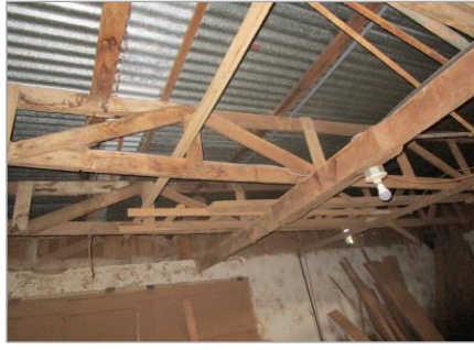
Estructura de cerchas, clavadores y cubierta de área de taller
