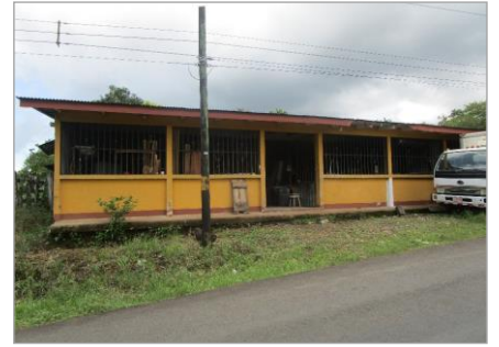
Vista del frente de la propiedad
