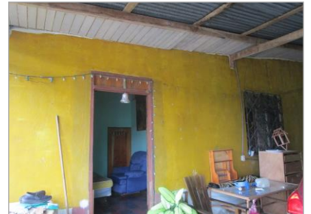
Vista del área de corredor
