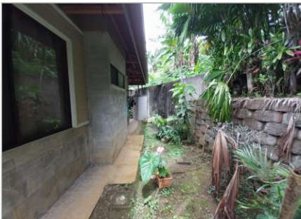
Vista lateral de la vivienda y muro.
