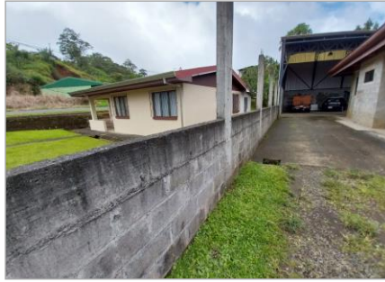
Tapia perimetral al Oeste.
