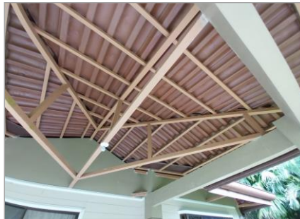
Estructura techo y Cielos.
