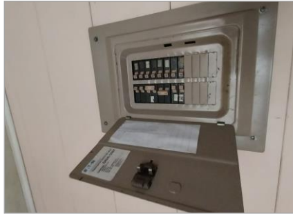
Caja de Breakers.
