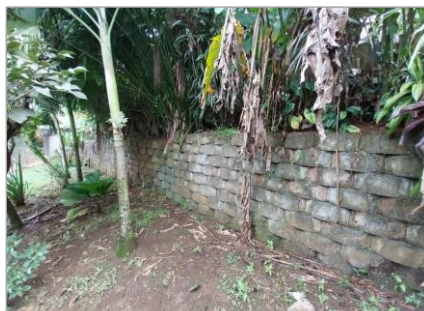
Muro en block escarpado.
