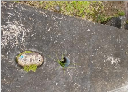
Medidor de agua.
