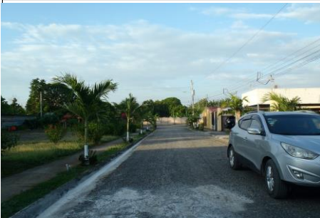
VISTA AL NORTE DE CALLE ACCESO
