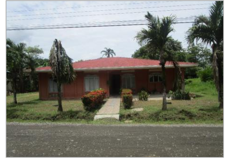
Vista de frente de la propiedad
