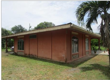
Vista de frente de la propiedad colindancia Norte
