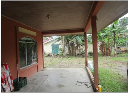
Área de pilas
