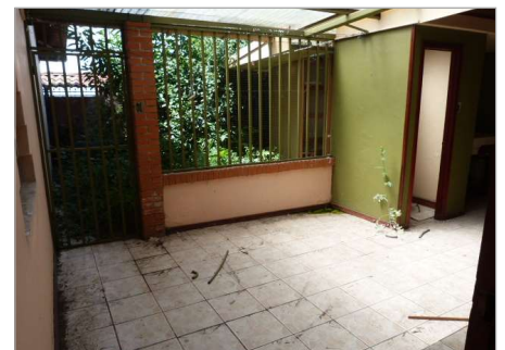
Patio tendido y pilas
