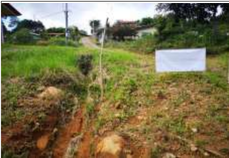
VISTA DE CAÑO HACIA LA FINCA, problemas de escorrentía
