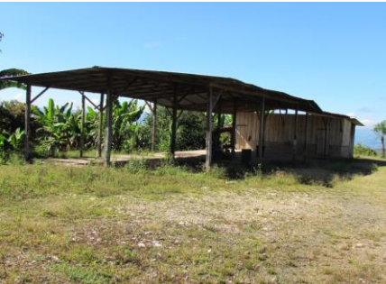
7. Cochera y bodega
