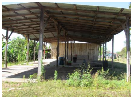
8. Cochera y bodega
