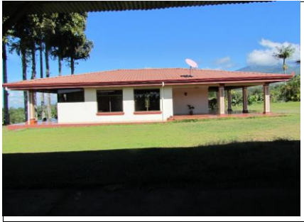
1. Casa habitación vista lateral
