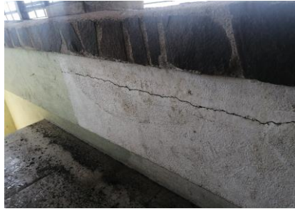
26. GRIETAS EN PAREDES
