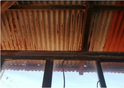
28. CUBIERTA DEL TECHO DAÑADO POR OXIDO
