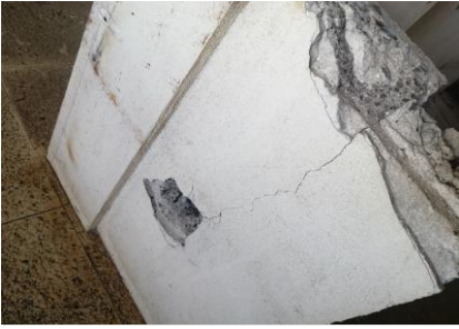
25. GRIETAS EN PAREDES
