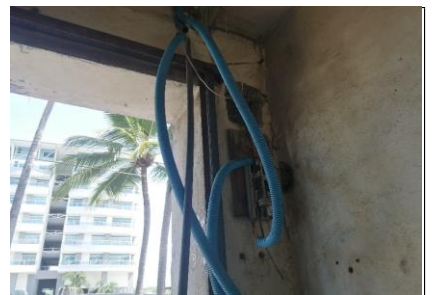
24. INSTALACION ELECTRICA EN MAL ESTADO
