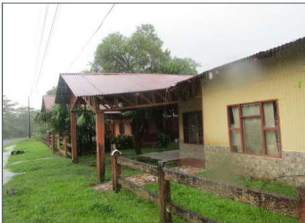
Fachadas posteriores del as viviendas
