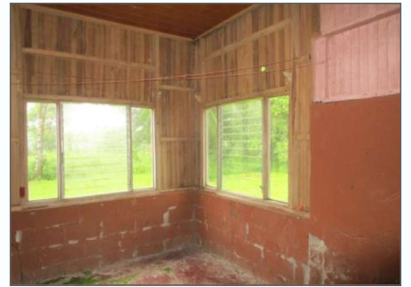
Vista interna de la vivienda principal
