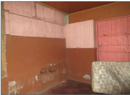
Vista interna de la vivienda principal
