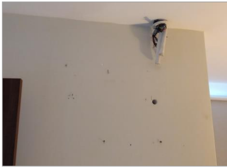
Prevista unidad de aire acondicionado
