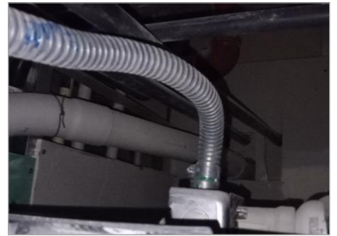
Detalle sistema eléctrico
