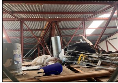
Estructura de techo
