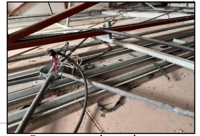
Estructura de techo
