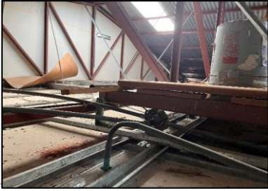
Estructura de techo
