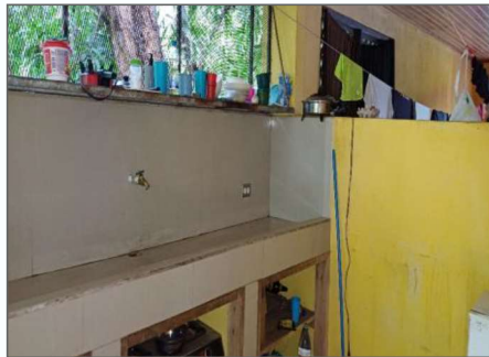
Cuarto de pilas
